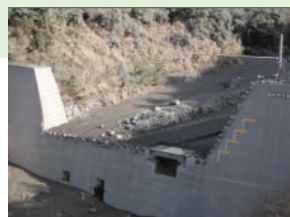
有村川における土石流観測
