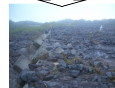
遊砂地工による流出土砂の捕捉状況（大沢川遊砂地）
