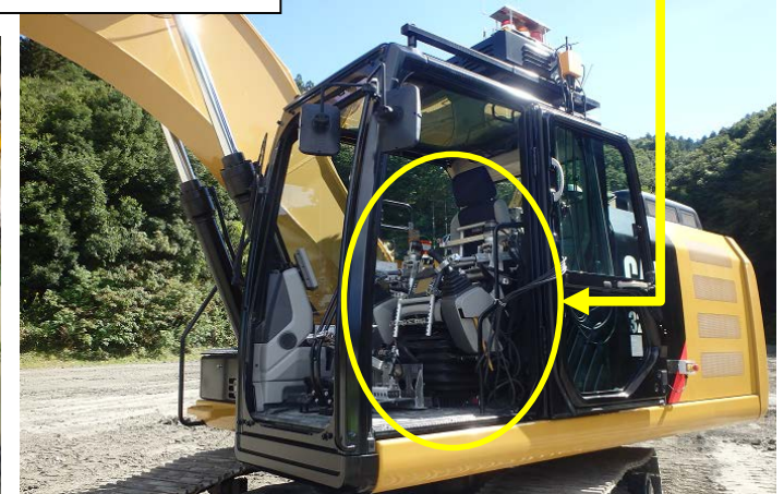
遠隔操縦装置の設置状況
