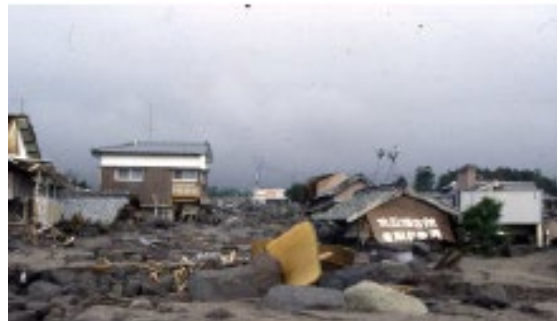
雲仙岳：土石流により被災した住宅（平成 5 年 6 月 20 日）
