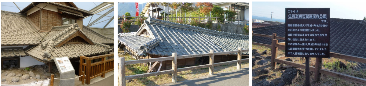
土石流被災家屋保存公園： 雲仙普賢岳噴火災害の土石流被害を受けた家屋が保存され展示されている。道の駅も隣接しており、訪れる家族連れや修学旅行生など観光客に、自然の脅威を伝えている。〔社会安全研究所撮影〕
