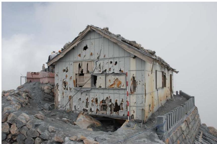
図1-3 御嶽神社頂上奥社外壁の被害状況
