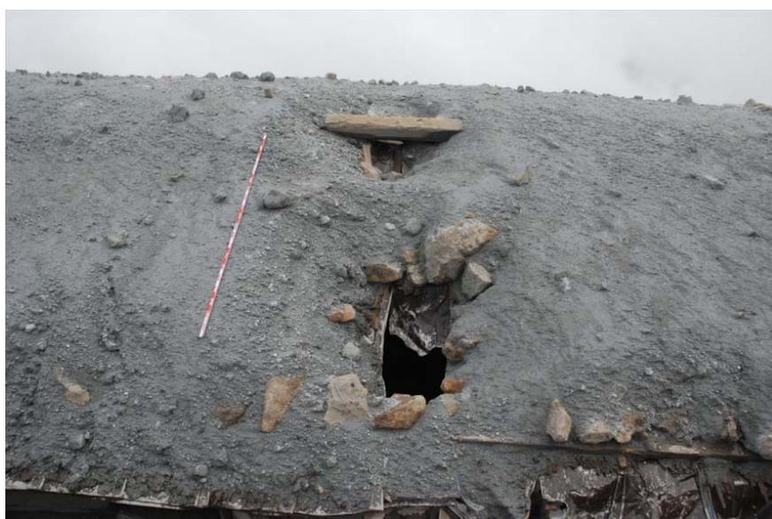
図1-4 御嶽剣ヶ峰山荘屋根の被害状況
