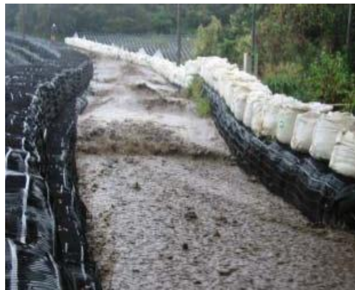
泥流流下のための仮設導流堤（三宅島）
