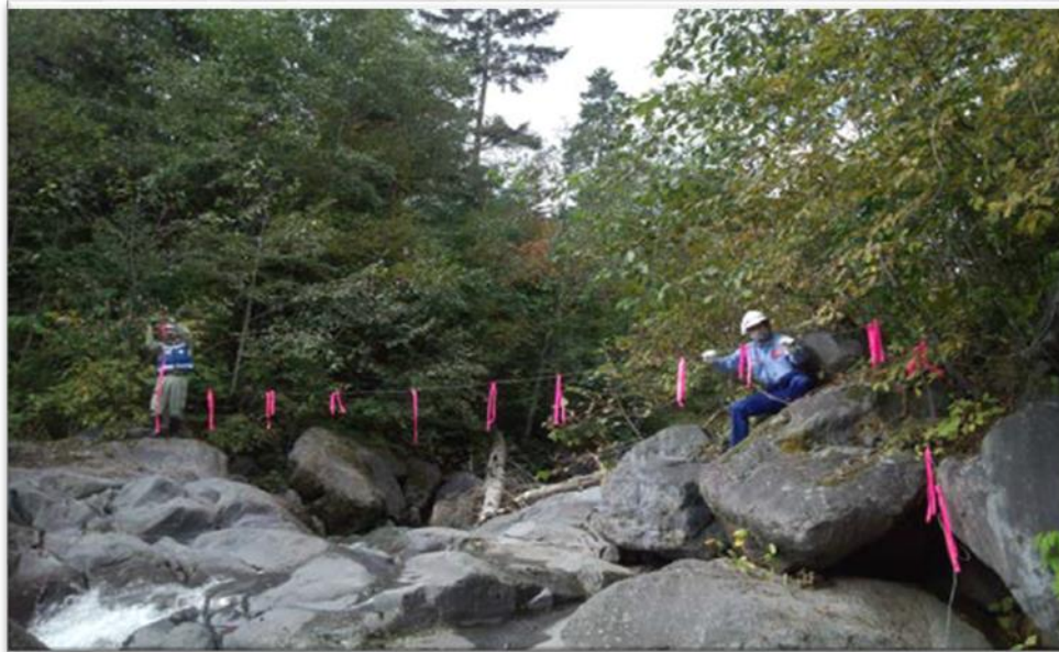
ワイヤーセンサーの設置
