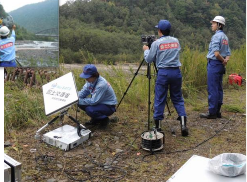
監視カメラの設置
