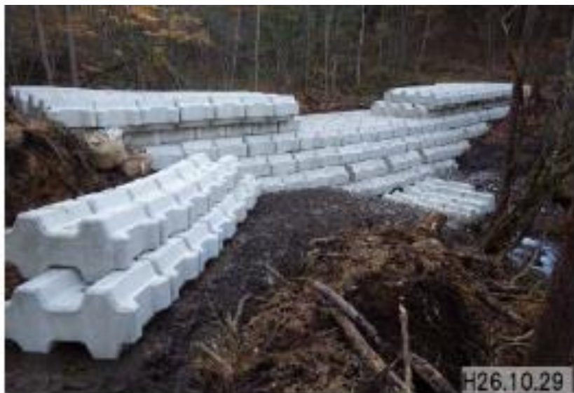
ブロック積による仮設の砂防堰堤（御嶽山）
