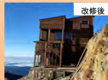
R3年度 防災シェルター整備 (長野県木曾町)
