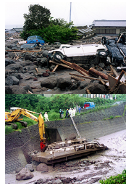
出典) 国土交通省九州地方整備局 雲仙復興事務所ホームページ
