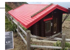
避難小屋 屋根改修工事(H29-H30)
