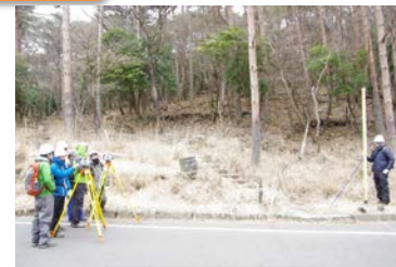
測量実習風景
