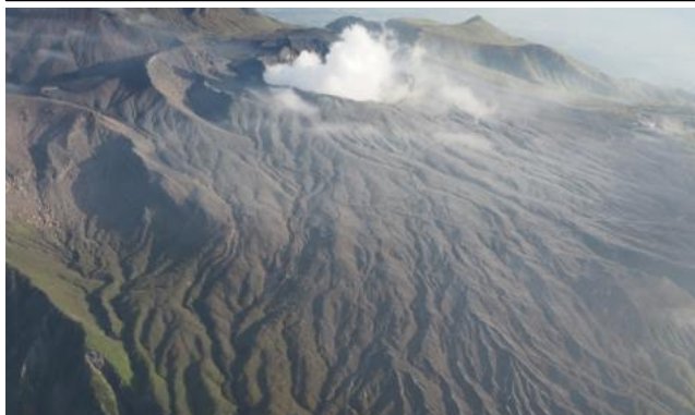
②ヘリからの北東斜面の調査状況 (流域全体に厚くは堆積していない)
