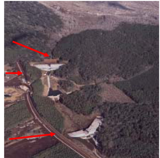
雲仙普賢岳に施工された火砕流熱風部対策用の柵工
