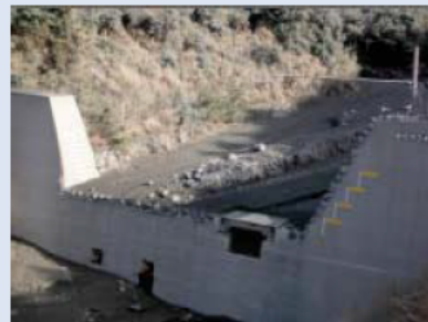
有村川第3砂防堰堤での観測
