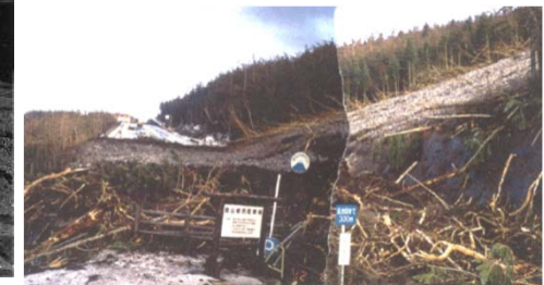
土石流により、5合目付近の富士スバルラインが寸断、6合目の県安全指導センターが被災(山梨県 H3)
