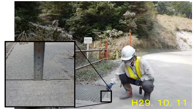
地上からの現地調査状況
