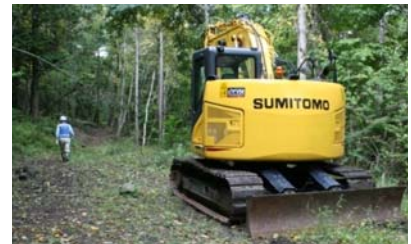
10月4日重機搬入状況
