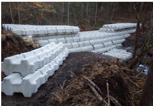
コンクリートブロック積み堰堤
