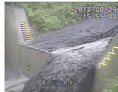
桜島有村川における土石流観測
