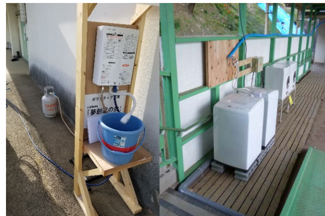
避難所に設置した簡易給湯器、洗濯機・乾燥機
