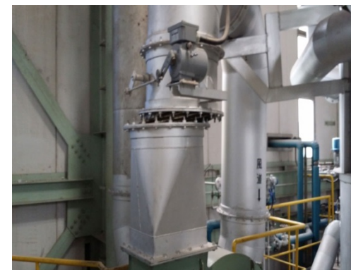
東部環境工場ボイラー破損
