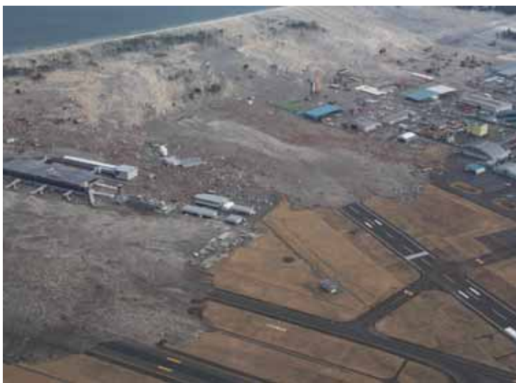
津波が押し寄せる仙台空港
