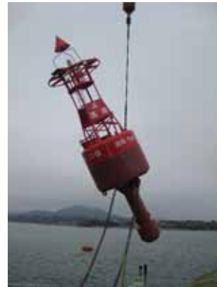
設置作業中（気仙沼港）
