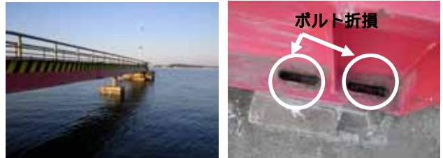
宮城海上保安部 船艇基地の被害状況
