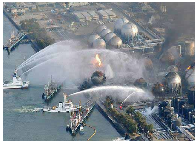
写真下部の小さい赤色は放水中の消防車です。
