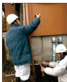
(住宅の傾斜の計測)
