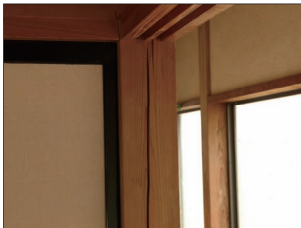
柱、梁に割れが見られる。
