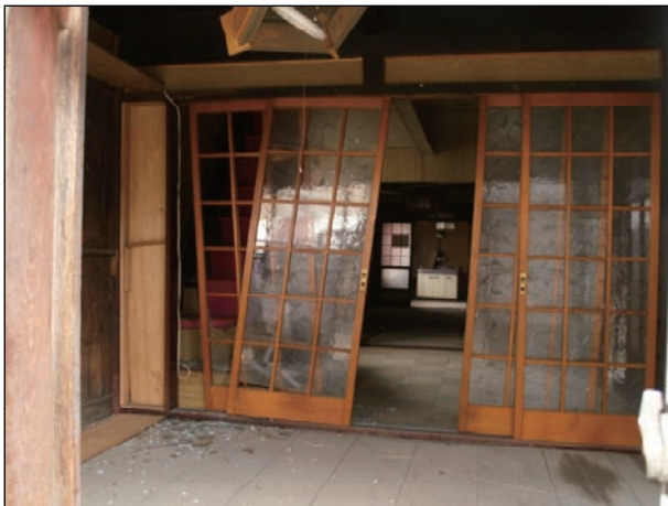
【襖、障子】 かまちの損傷が著しく、交換が必要である。
