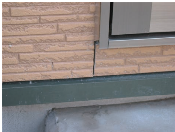
目地部にわずかなずれが生じている。
