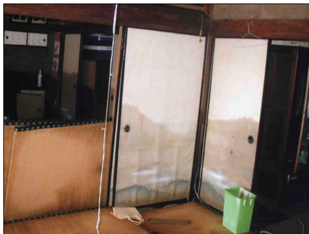
浸水による襖・障子・ドアの破損(表面、格子・縁の洗浄、張り替えによって、再使用が可能な程度)
