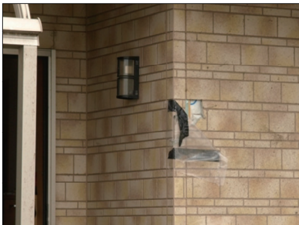
壁に飛来物の軽微な衝突痕がある。
