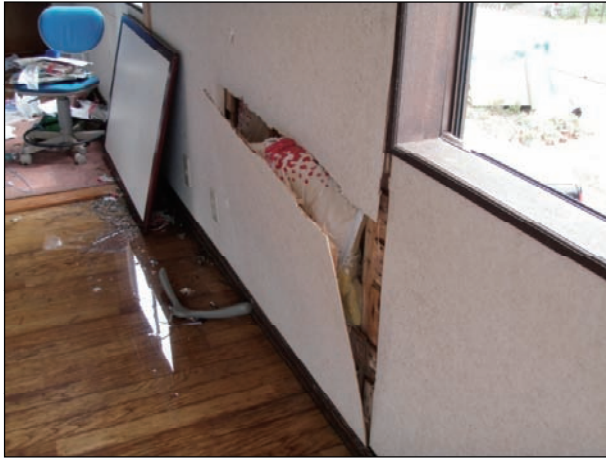
内壁合板に剥離、脱落が見られる。
