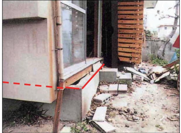
土台が基礎から著しくずれている。
