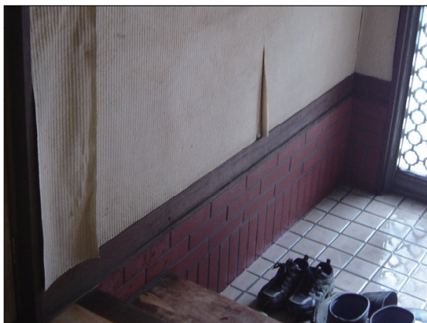
浸水により壁クロス汚損・表面劣化・剥離等が見られる。(下地材の交換を要しない程度)
