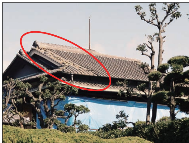
棟瓦以外の瓦もずれが著しい。
