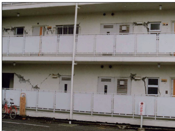
【鉄筋コンクリート造】 8401
