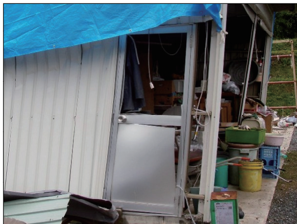
【アルミドア】 破壊されている。
