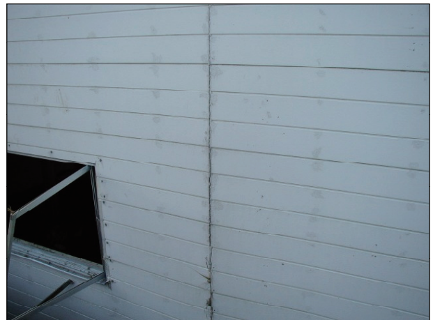
ボード仕上の壁では一部のボードの仕上面の目地部にひび割れやずれが生じている。
