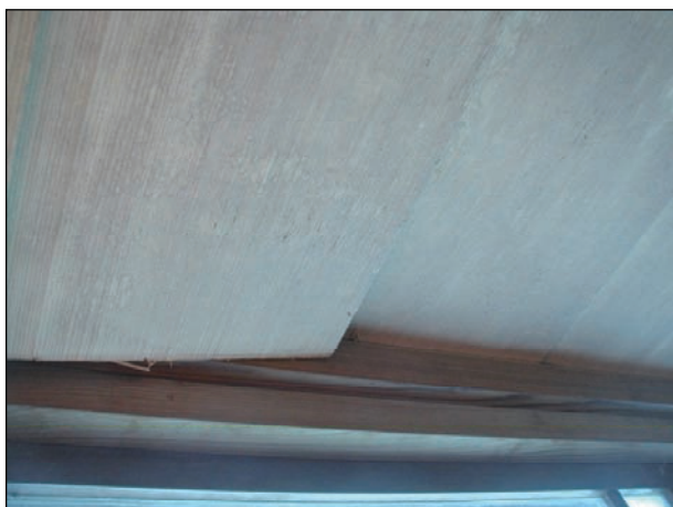
天井板の浮きが生じている。
