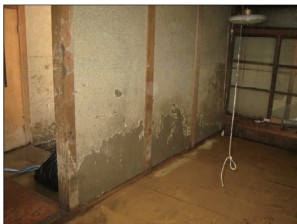
浸水により仕上塗壁材の剥離等が見られる。
