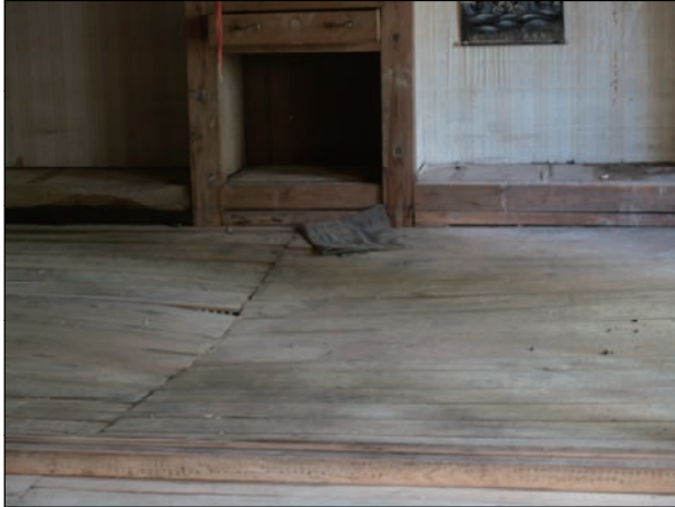
床板に著しい不陸、折損が見られる。
