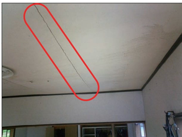
塗天井に亀裂が生じている。
