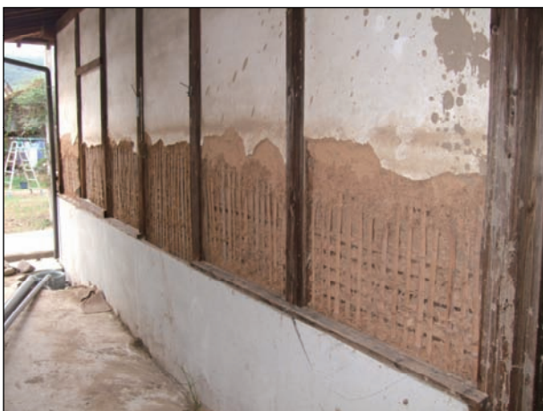
塗り壁では仕上の大半が剥離又は脱落している。
