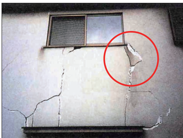
仕上の剥離が生じている。
