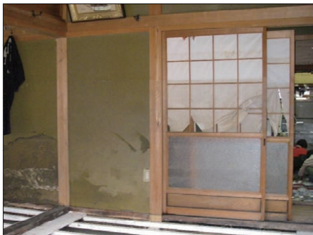
浸水による襖・障子・ドアの破損(表面、格子・縁の洗浄、張り替えによって、再使用が可能な程度)
