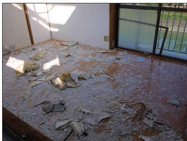
浸水により床板の汚損が見られる。
