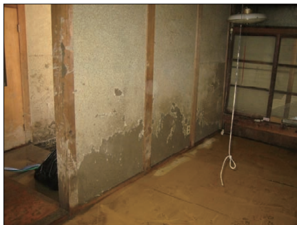
浸水により壁クロス汚損・表面劣化・剥離等が見られる。(下地材の交換を要しない程度)
