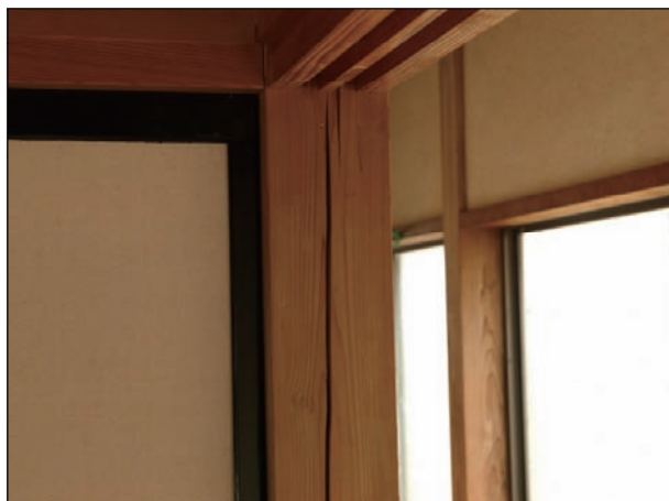
柱、梁に割れが見られる。
