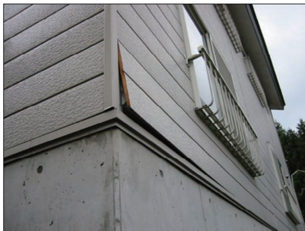
目地部に著しいずれ、面材釘打部の部分的な浮き上がり、ボード隅角部の破損が生じている。
