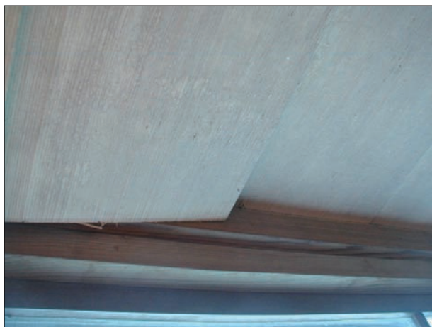
天井板の浮きが生じている。
