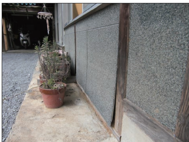
仕上の剥離が生じている。
