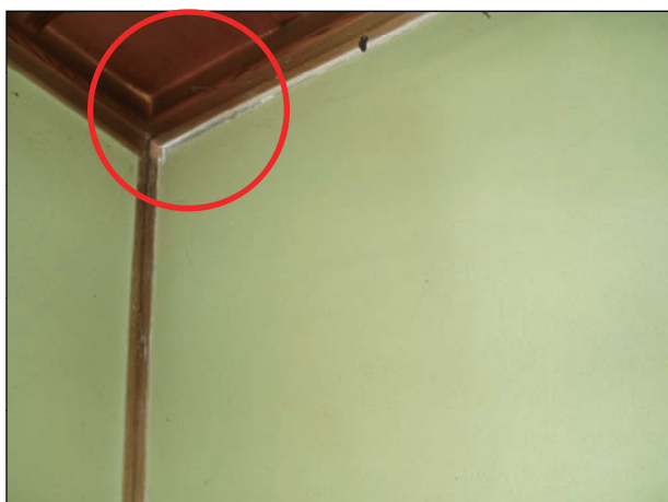
内壁周辺部に隙間が生じている。
