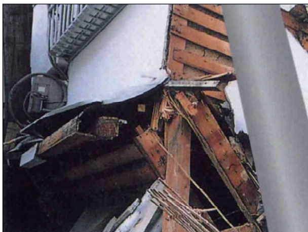
柱、梁の割れ、断面欠損が著しい。
