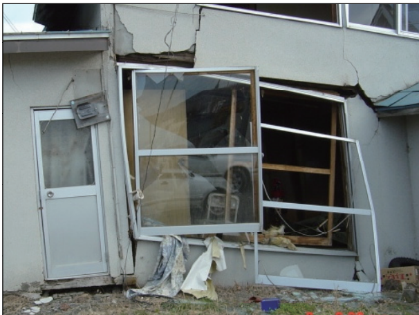
【アルミサッシ】 枠ごとはずれて破壊されている。
