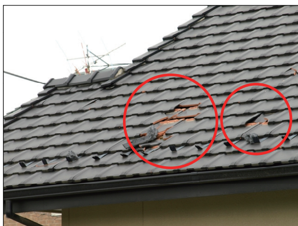
屋根の一部に飛来物による軽微な衝突痕がある。
