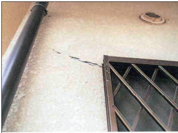
開口隅角部廻りにわずかなひび割れが生じている。
