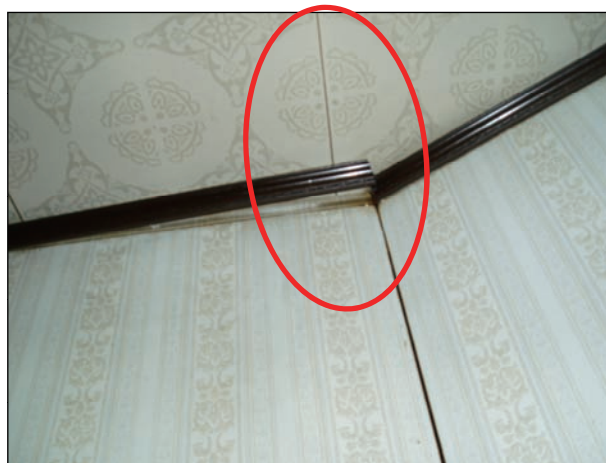
・天井板にわずかな隙間が生じている。
