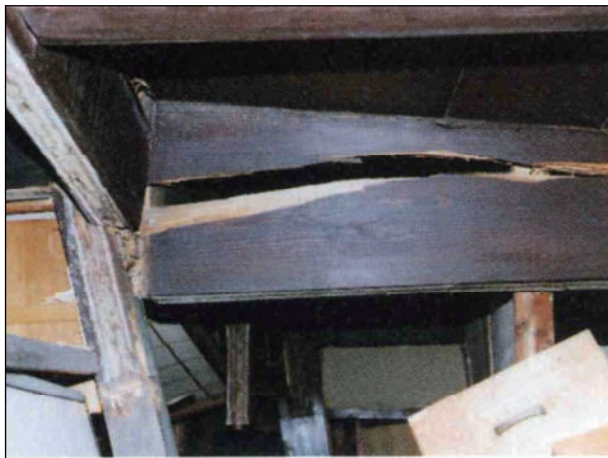
柱、梁に大きな割れが見られる。
