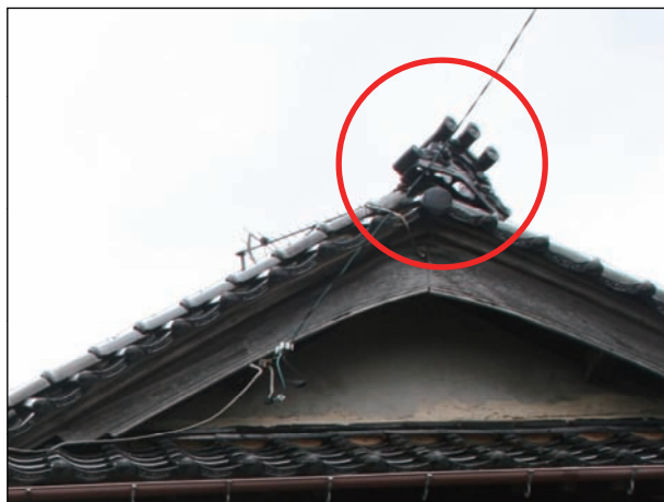
棟瓦(がんぶり瓦、のし瓦)の一部がずれ、破損が生じている。 (棟瓦の損傷が認められる場合は棟瓦を挟む両屋根面で損傷を算定する。)
