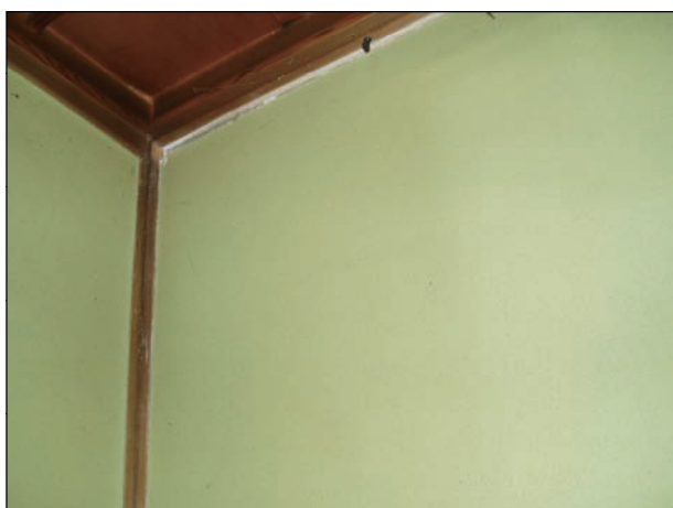
内壁周辺部に隙間が生じている。
