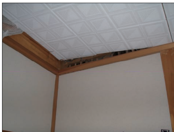
天井板の浮きが生じている。
