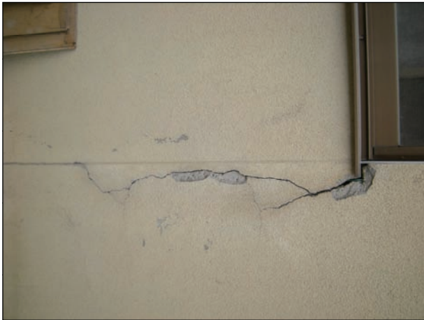
塗り壁の開口部隅角部廻りにわずかなずれが生じている。
