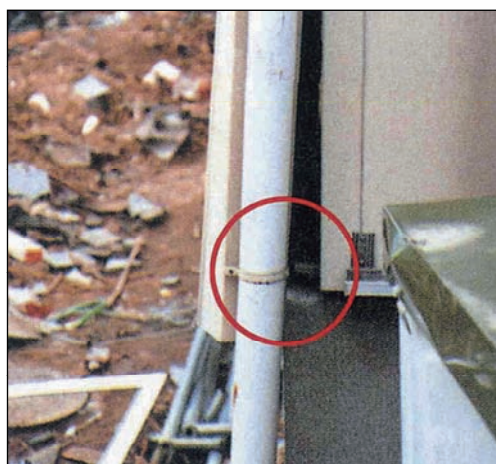
アンカーボルトの伸びが見られる。
