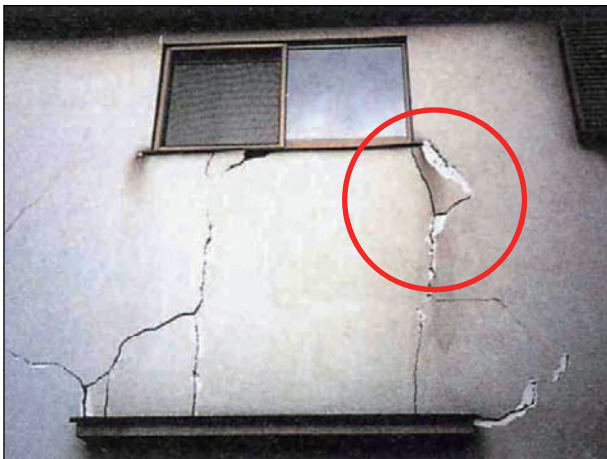
塗り壁の各所で仕上の剥離が生じている。
