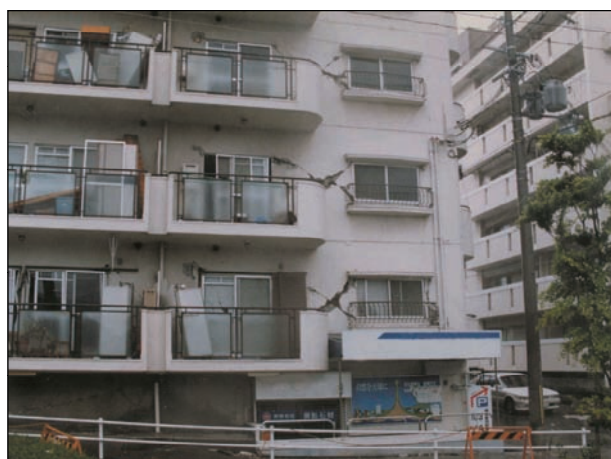
【鉄筋コンクリート造】 8403
