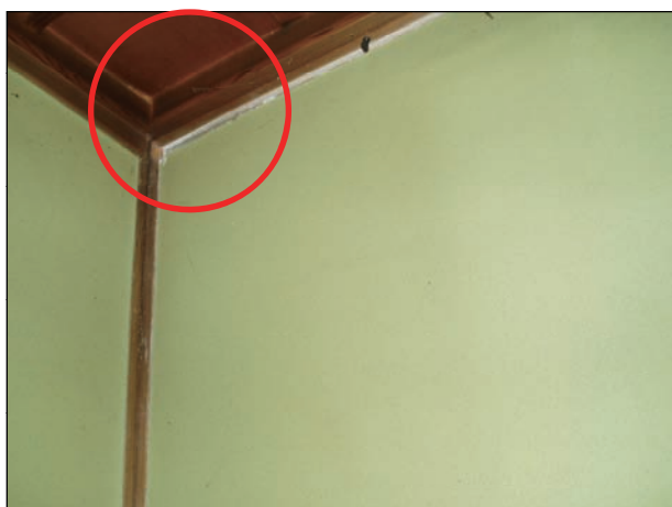
内壁周辺部に隙間が生じている。
