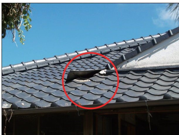
浸水により屋根葺材等に浮きが見られる。
