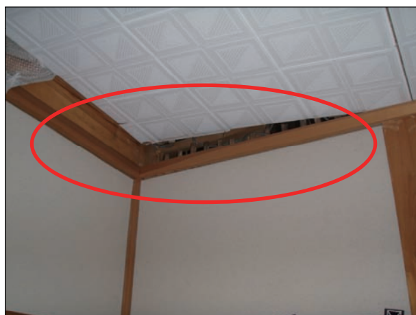
天井板の浮きが生じている。
