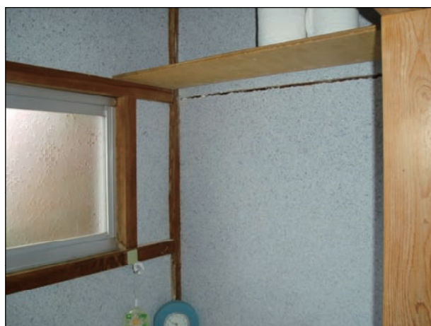
ボードの目地部にひび割れやずれが生じている。
