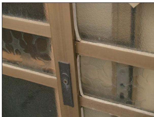
【アルミサッシ】 鍵の破損や、ビードのはずれが見られる。
