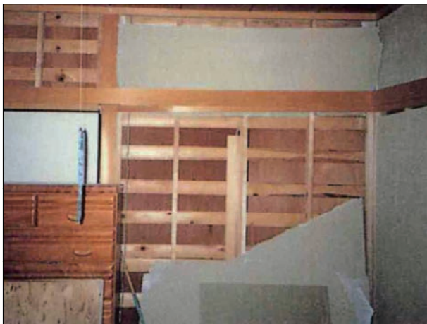
仕上材が脱落しており、下地材の損傷が生じている。
