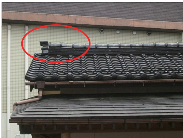
棟瓦(がんぶり瓦、のし瓦)の一部がずれ、破損が生じている。 (棟瓦の損傷が認められる場合は棟瓦を挟む両屋根面で損傷を算定する。)
