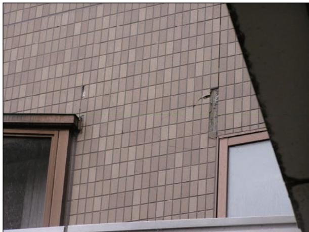
【外部仕上】 9301 仕上材のわずかな剥離、目地のずれが見られる。
