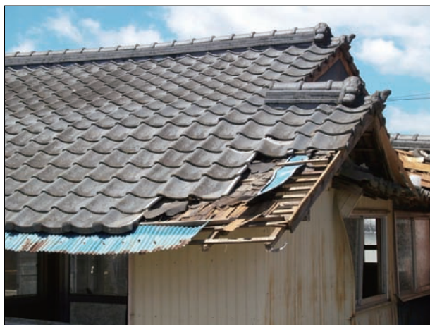
浸水により下地材の損傷が見られる。
