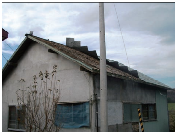
金属版葺材の半分程度がはがれている。
