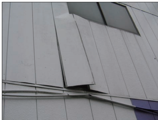
ボード仕上の壁ではボード間に著しいずれが生じている。
