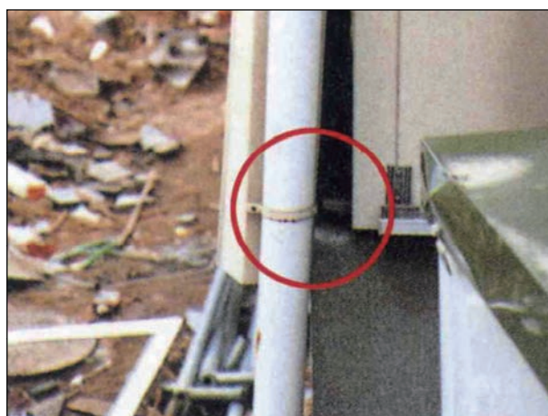
アンカーボルトの伸びが見られる。
