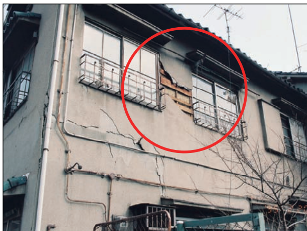
仕上材が脱落している。
