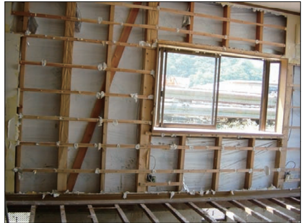
浸水により断熱材の吸水による機能損失(再使用が不可能な程度)が見られるため、耐力壁の一部(ボード等)の取り外しが必要である。
