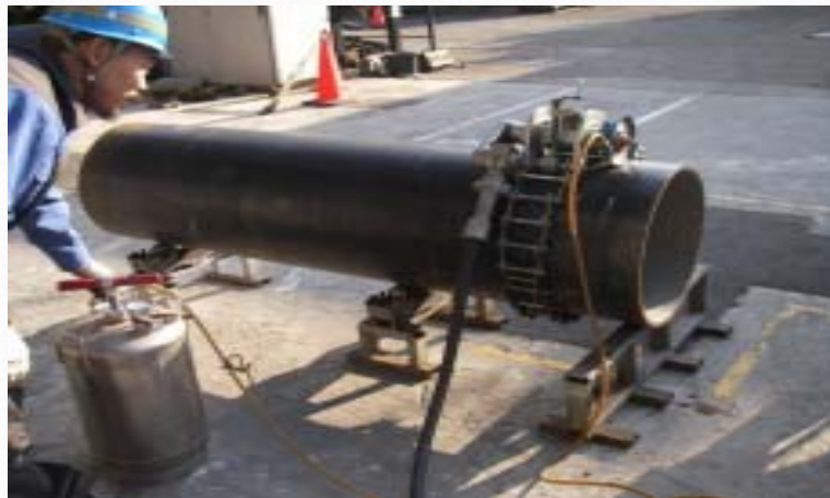
訓練の様子 配水管切断訓練
