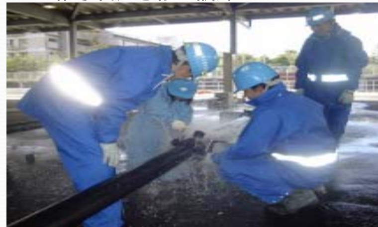
配水管応急修理訓練
