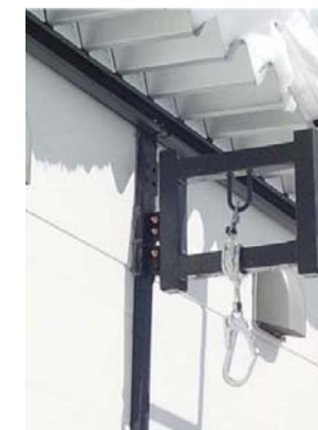
雪下ろしのための 金物の設置
