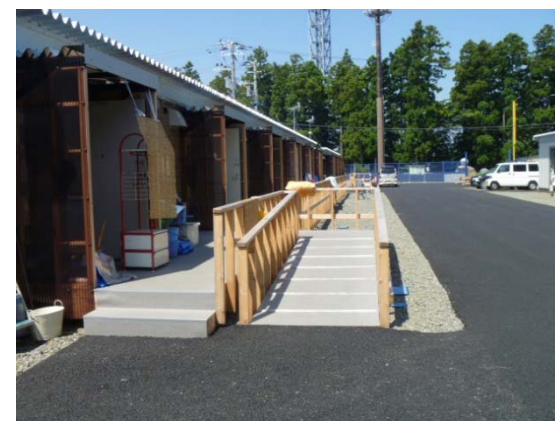
住戸前の舗装、スロープの設置
