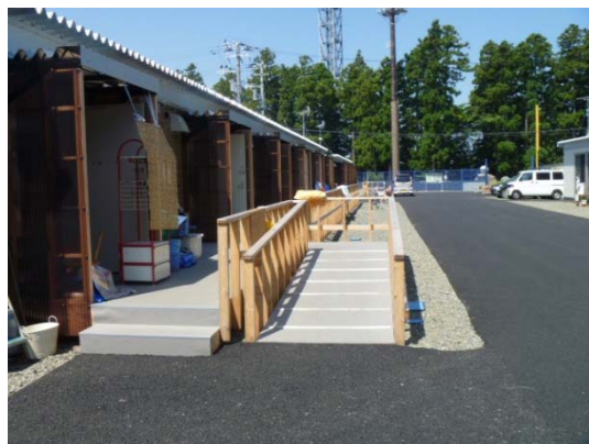
住戸前の舗装、スロープの設置
