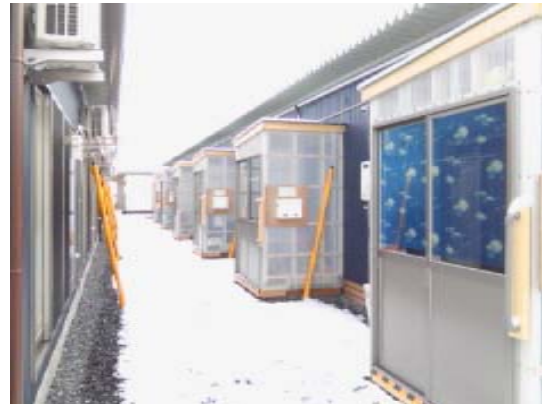
風除室の設置
