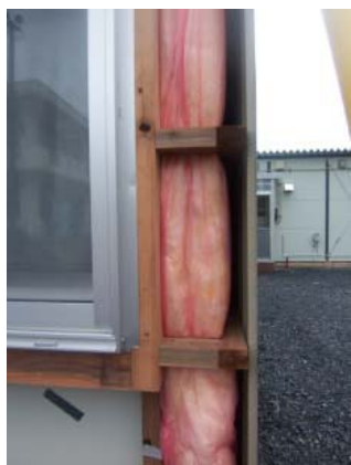
追加工事による 外断熱
