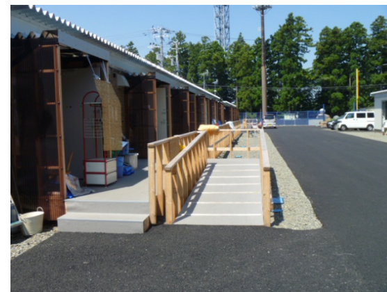
住戸前の舗装、スロープの設置
