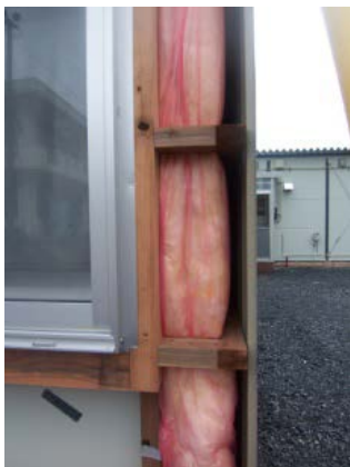
追加工事による 外断熱
