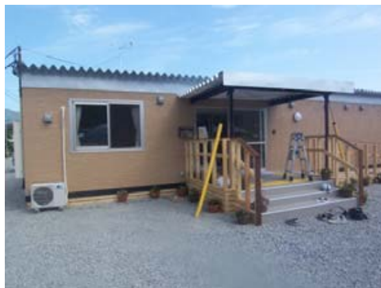
グループホーム型仮設住宅
