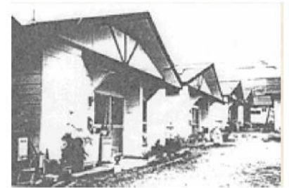
改修による恒久化 ※
