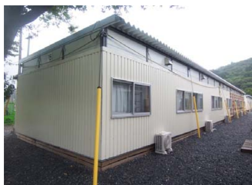
事例3: 追加工事による外断熱
