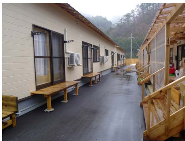
事例2: 縁台やベンチの設置(奈良県野迫川村)
