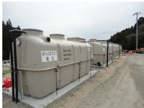
事例2:浄化槽の設置
