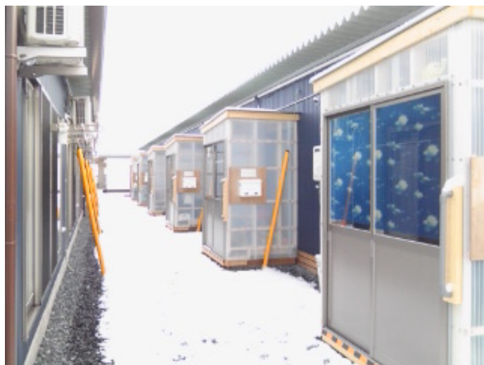
事例1: 風除室の設置(宮城県石巻市)
