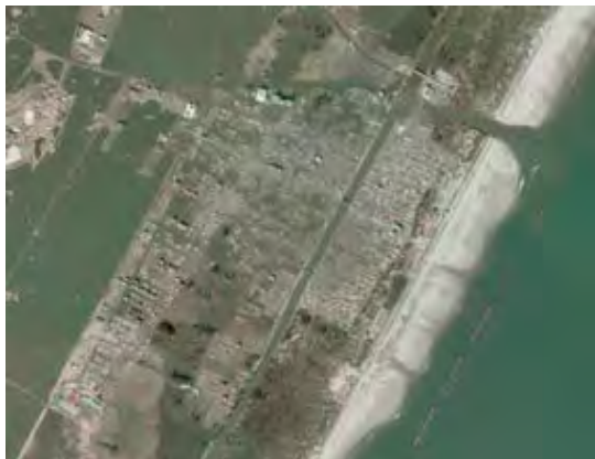
空中写真(東北地方太平洋沖地震:仙台市若林区荒浜周辺) 上:被災前(2008年撮影) 下:被災後(2011年3月12日撮影)
