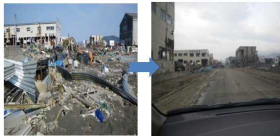
(石巻市内の災害廃棄物の撤去状況)
