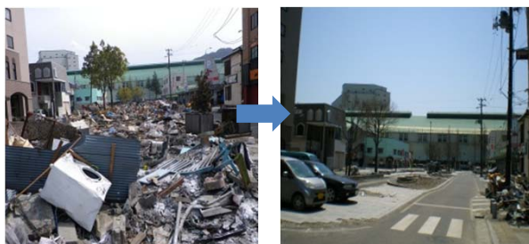
(釜石市内の災害廃棄物の撤去状況)
