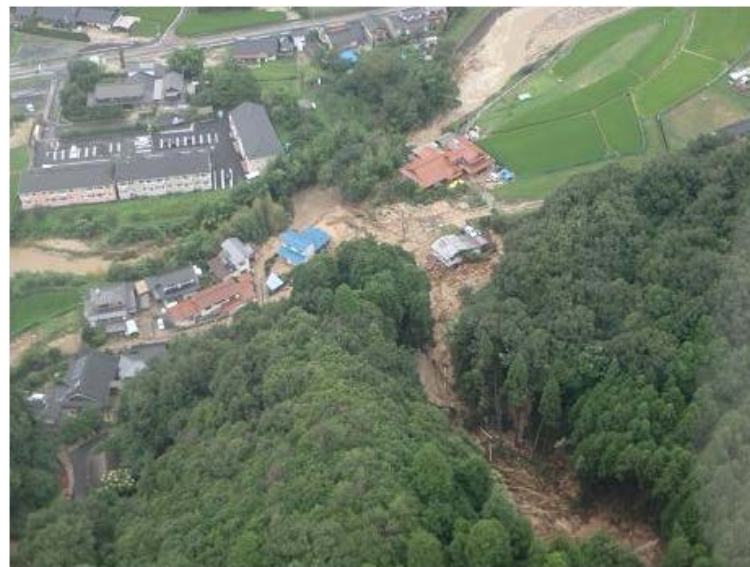
国土交通省の防災ヘリ「愛らんど号」からの被害状況調査
