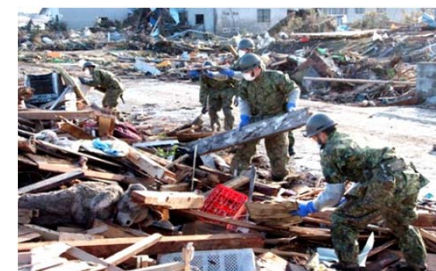
▼がれきの撤去作業
