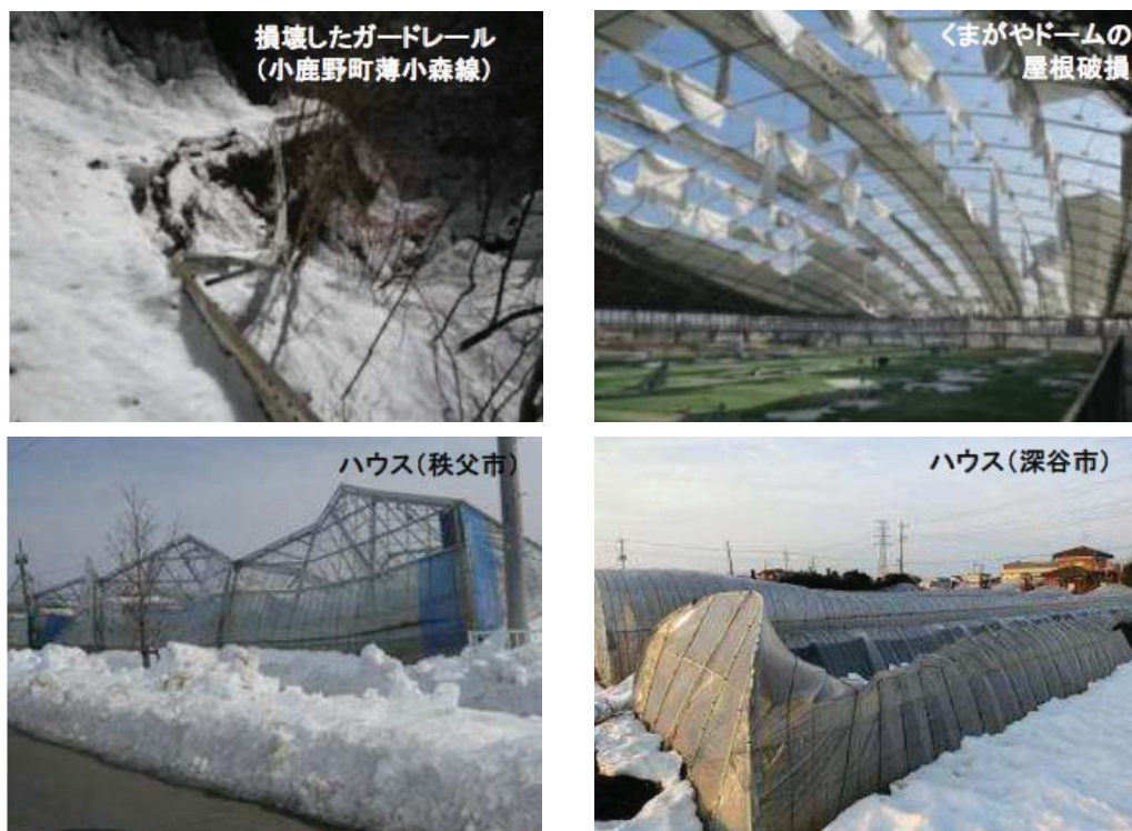
図 埼玉県における被害状況写真
