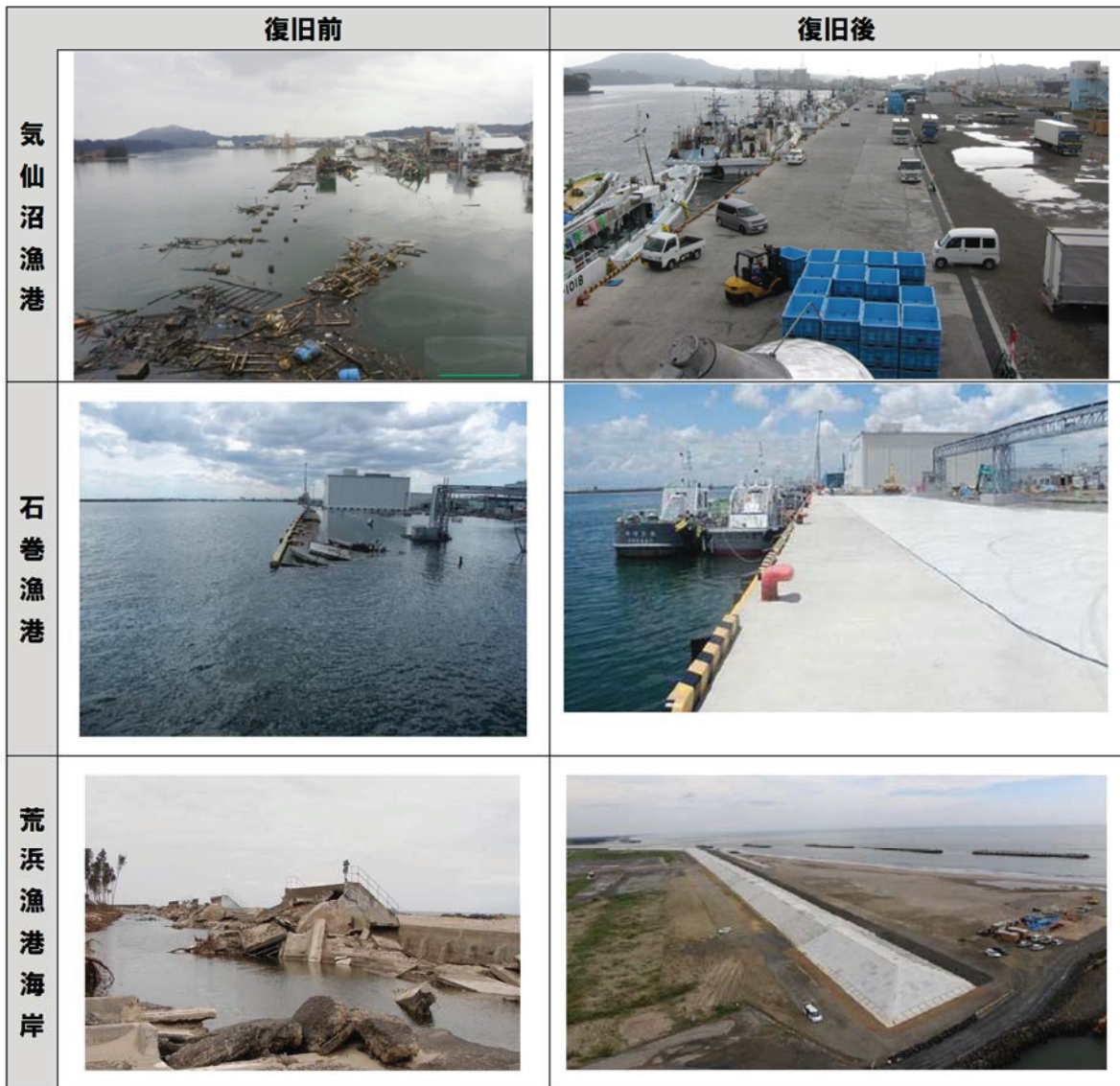
図 3 施設の被害状況
