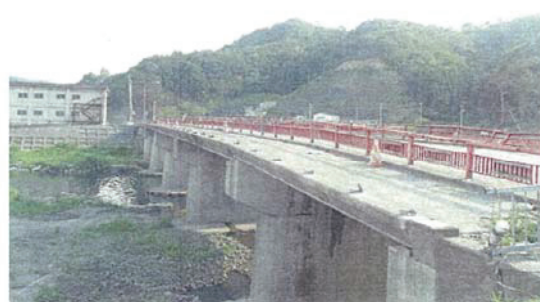
大槌橋（橋梁上部工損傷）
