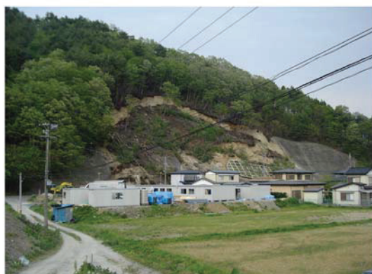
一級町道小槌線（法面崩壊）
