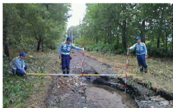
四国地整河川班 久山川沿い被災状況調査
