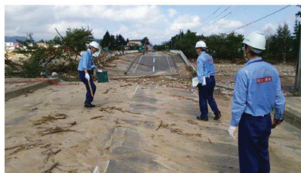
中国地整道路班 ベケレベツ川 橋梁調査
