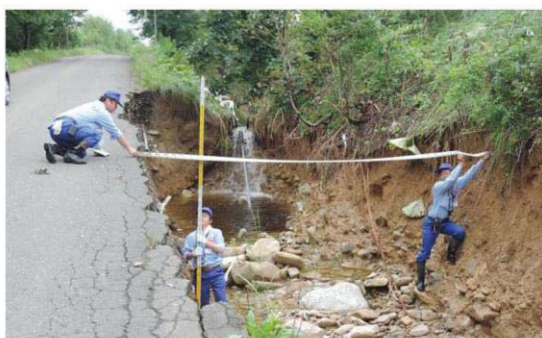
網走開建道路班 町道洗掘箇所調査
