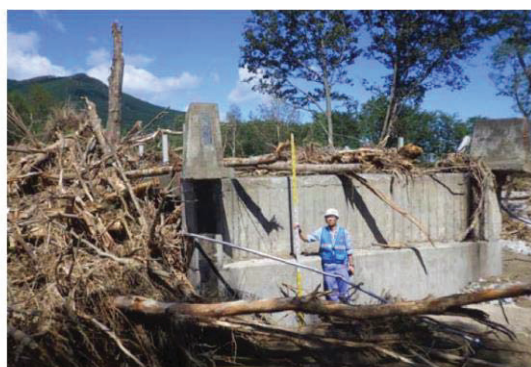
関東地整道路班 橋梁被災箇所の調査
