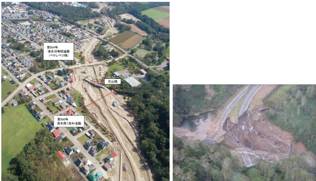
図 清水町の被害状況
