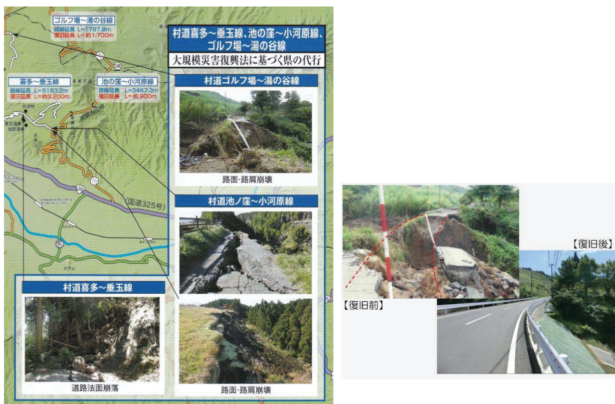
図 村道3路線の被害状況と復旧状況
