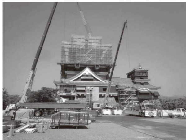
天守閣（復旧工事着工後の状況）
