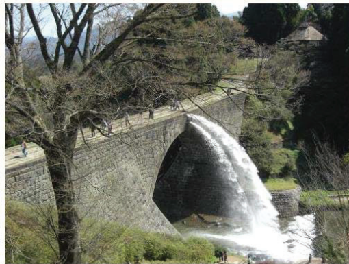
通潤橋の放水 [山都町教育委員会 撮影]
