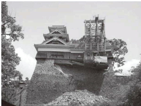
飯田丸五階櫓（応急対策後の状況）
