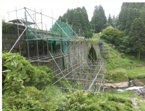
写真1 仮設足場を設置した通潤橋 [平成29年6月1日 生涯学習課 撮影]
