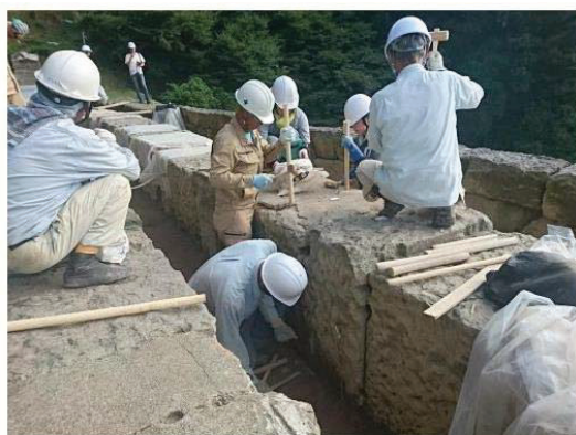
写真9 漆喰の充填作業(1) [生涯学習課 撮影]
