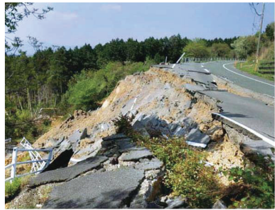
路肩の崩壊 (西原村小森)
