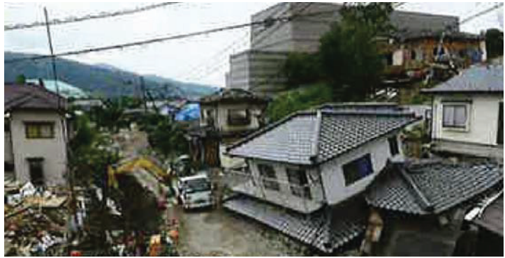
家屋の倒壊 (益城町)
