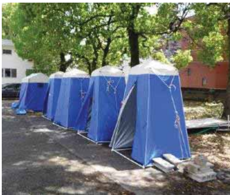
図 マンホールトイレの設置状況
