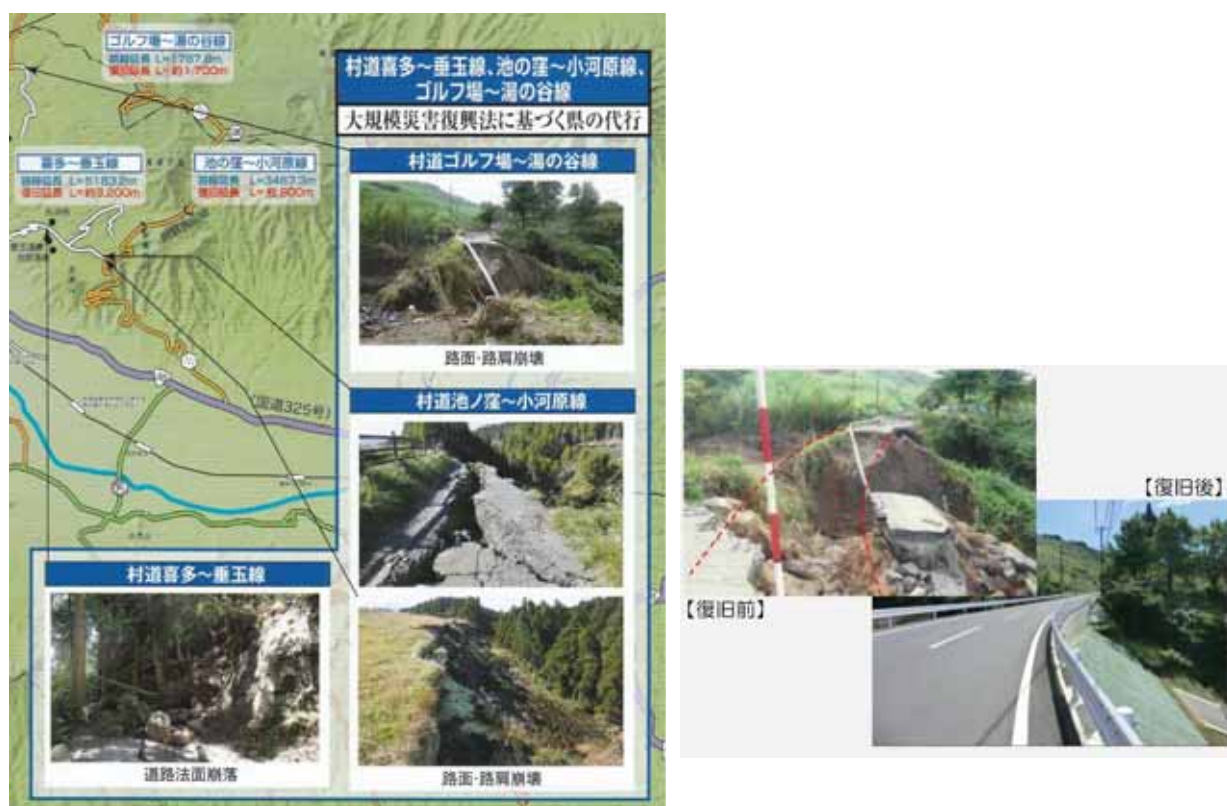
図 村道3路線の被害状況と復旧状況
