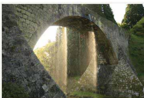
写真1 熊本地震直後の漏水状況(1) [平成28年4月16日 生涯学習課 撮影]
