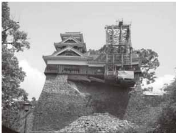
飯田丸五階櫓（応急対策後の状況）
