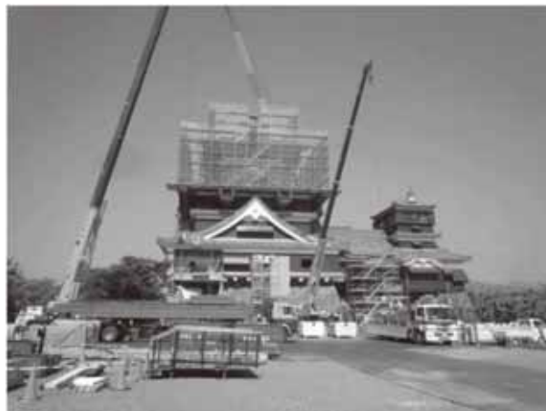
天守閣（復旧工事着工後の状況）
