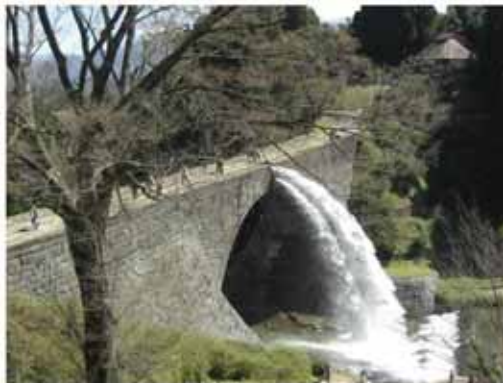
通潤橋の放水 [山都町教育委員会 撮影]
