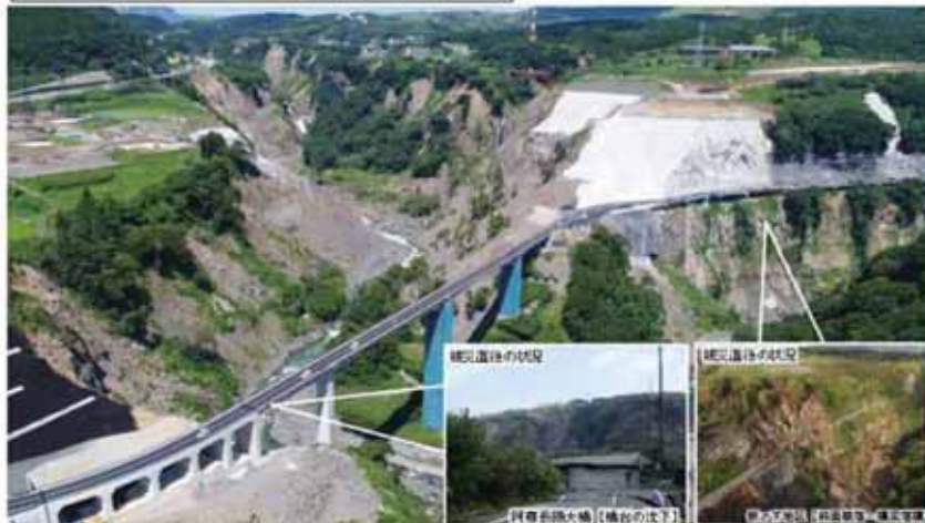
図 村道栃の木～立野線復旧の様子
