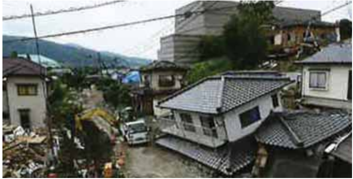
家屋の倒壊 (益城町)
