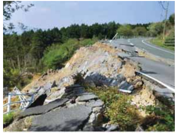
路肩の崩壊 (西原村小森)
