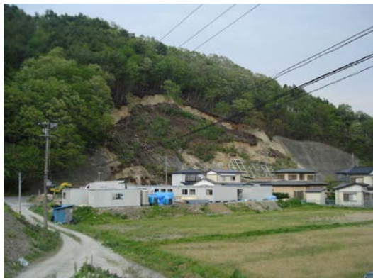
一級町道小槌線（法面崩壊）
