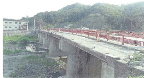
大槌橋（橋梁上部工損傷）
