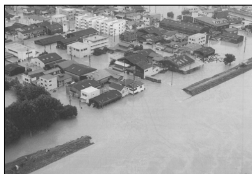
写真1 新川破堤箇所(西区あし原町)
