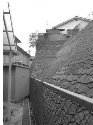
保育園の裏側 (地震時にがけが崩れ土砂が保育園に流入)
