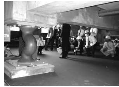
免震装置（鉛ダンパー）
