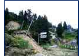
中山間地での地震被害の様子
