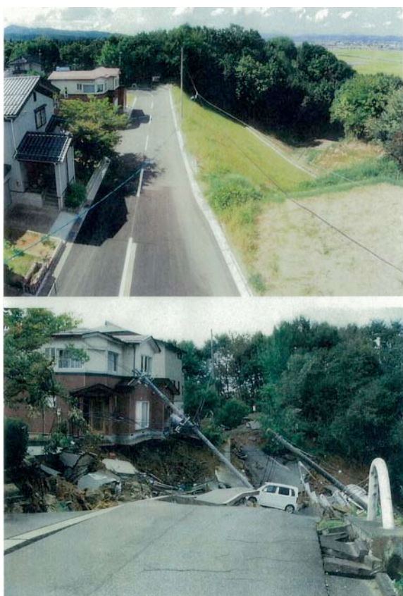
写真1 被害と復旧の状況 6)
