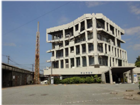
【宇土市役所の被災状況】
