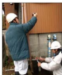
(住宅の傾斜の計測)
