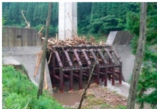
透過型砂防堰堤<sup>えんてい</sup>による流木捕捉事例
