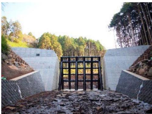
流木捕捉効果の高い透過型砂防堰堤<sup>えんてい</sup>
