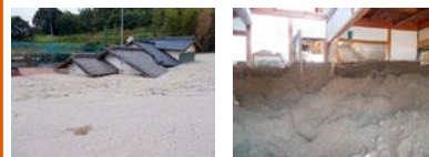
<平成29年九州北部豪雨での土砂堆積による住家被害の例>
