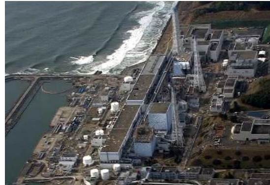
写真 事故が発生した東京電力福島第一原子力発電所の様子（上：4月26日、下：3月21日、3号機）
