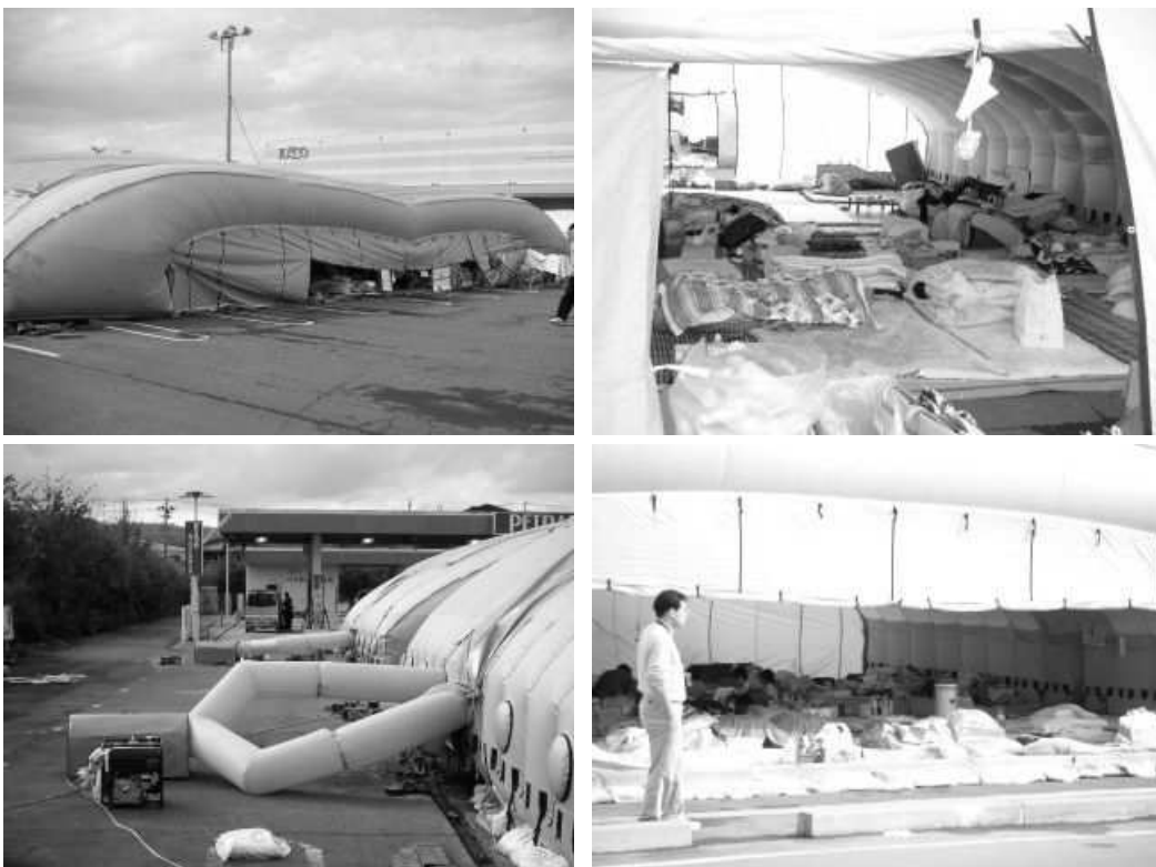
図 2-15 NGOが設置した緊急支援用大型テント（バルーンシェルター）の設置風景 (株式会社三菱総合研究所提供)
