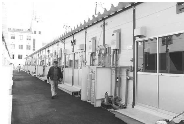
図 2-4 阪神・淡路大震災における神戸市の応急仮設住宅
