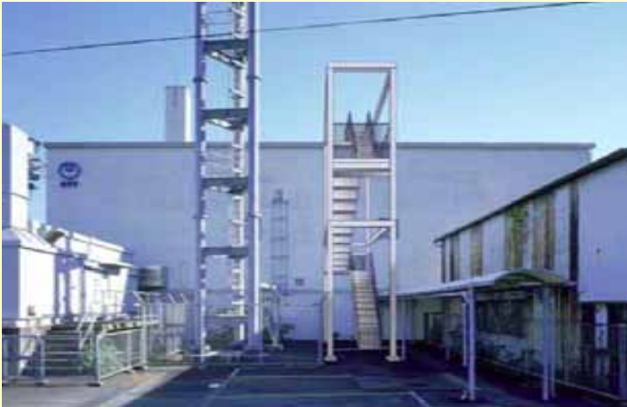
外階段設置(紀伊長島ビル)
