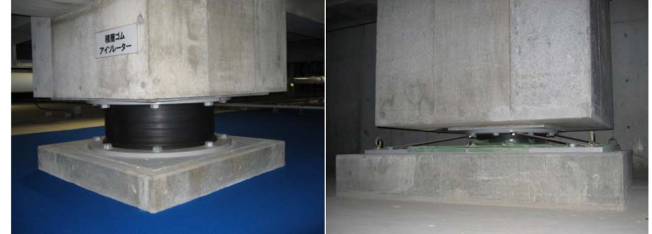
積層ゴムアイソレータ41体 (荷重支持+長周期化)
