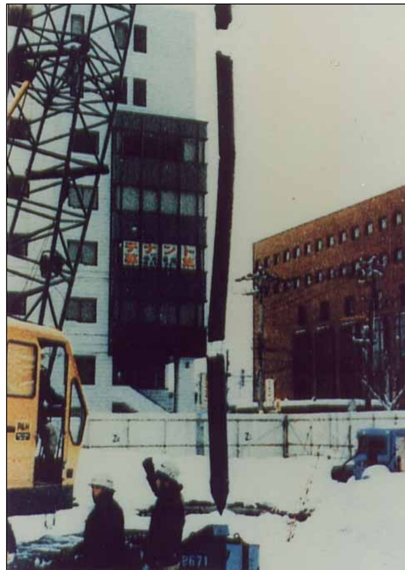
旧NHKビル基礎杭の被害(大成建設・河村氏提供)
