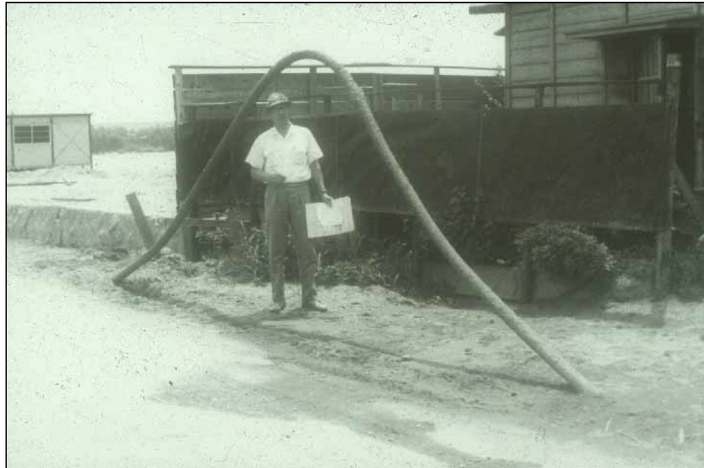
地盤の圧縮ひずみによる埋設管の座屈 (1964年新潟地震)
